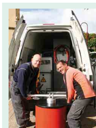
1 Das Messwagenteam aus Oschersleben beim Vorbereiten der Teilentladungsprüfung
