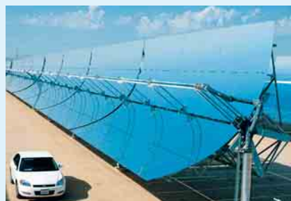
1 Parabolspiegel in einem Solarkraftwerk in Kalifornien Foto: Solar Millennium
