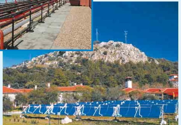
5 CSP-Anlage mit Parabolkollektoren für die solare Klimatisierung eines Hotels an der südlichen Mittelmeerküste in der Türkei
