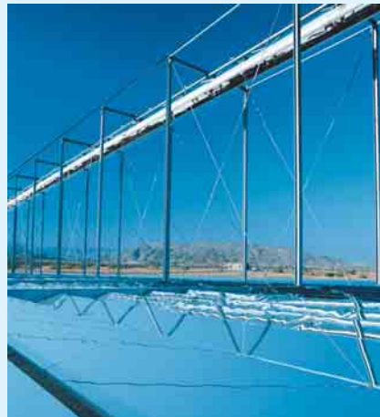
2 CSP-System mit Fresnelspiegeln
