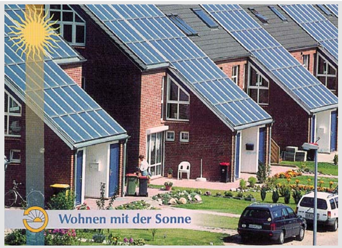
8 3000 m 2 Kollektorfläche auf 124 Reihenhäusern erhitzen einen unterirdischen 4500 m 3 großen Heißwasserspeicher. Im Winter liefert die gespeicherte Wärme 50 % des Wärmebedarfs aller Häuser.
