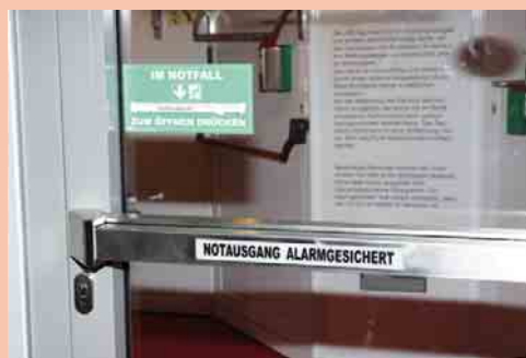
1 Druckstange mit integrierter Notausgangsüberwachungsfunktion
