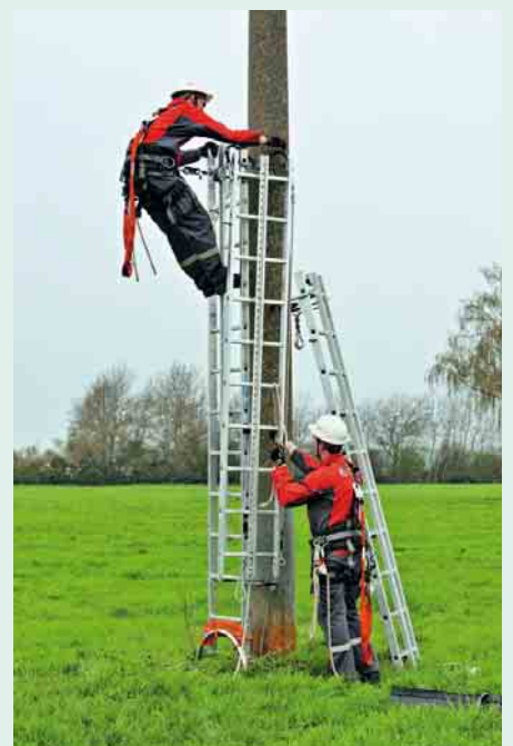
③ Zwei Erdspitzen an der Mastunterleiter sorgen für festen Halt, die Mittelstücke können je nach Höhe und Bedarf nachgerüstet werden
