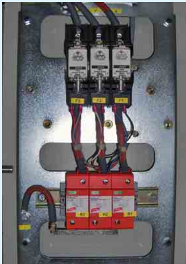
8 Blitzductor XT mit stationärer Überwachungseinheit (Condition Monitoring)
