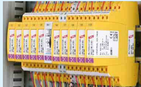
8 Blitzductor XT mit stationärer Überwachungseinheit (Condition Monitoring)
