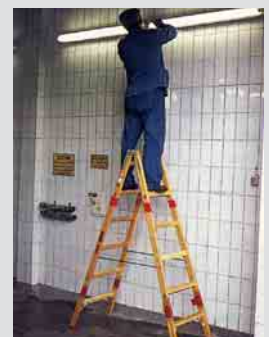
3 Stehleiter – korrekte Nutzung: Spreizsicherungen (Ketten) straff gespannt, oberste Sprossen nicht besteigen, Aufstellung auf ebenem Boden
