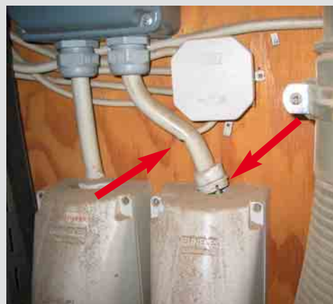
❶ Fehlerhafte Hohlwandinstallation – zwei Leitungen in der Leitungseinführung des Schalters, eine mechanisch ungeschützte Hohlwanddose und unzureichend befestigte Leitungen
