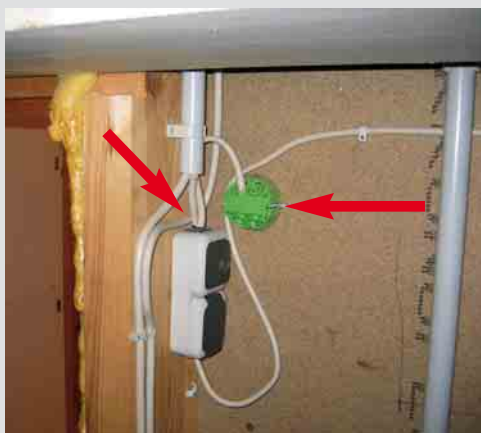
❶ Fehlerhafte Hohlwandinstallation – zwei Leitungen in der Leitungseinführung des Schalters, eine mechanisch ungeschützte Hohlwanddose und unzureichend befestigte Leitungen
