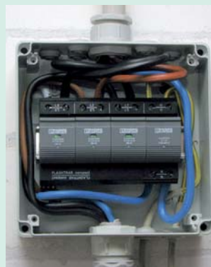
1 ÜSE Typ 1 schützt in V-Verdrahtung das Stromsystem
