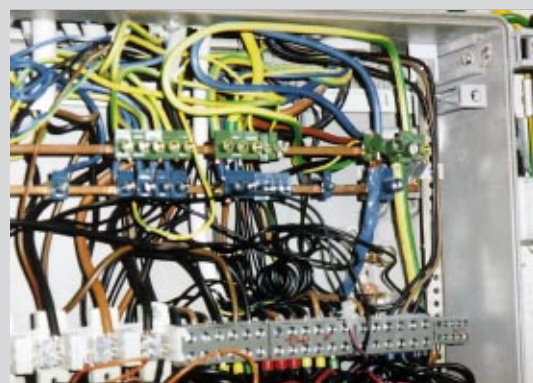
Bild 2: Lebensgefährdende Ausführung von Feuchtrauminstallationen in Schwimmbädern
