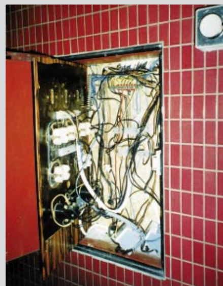
Bild 2: Lebensgefährdende Ausführung von Feuchtrauminstallationen in Schwimmbädern
