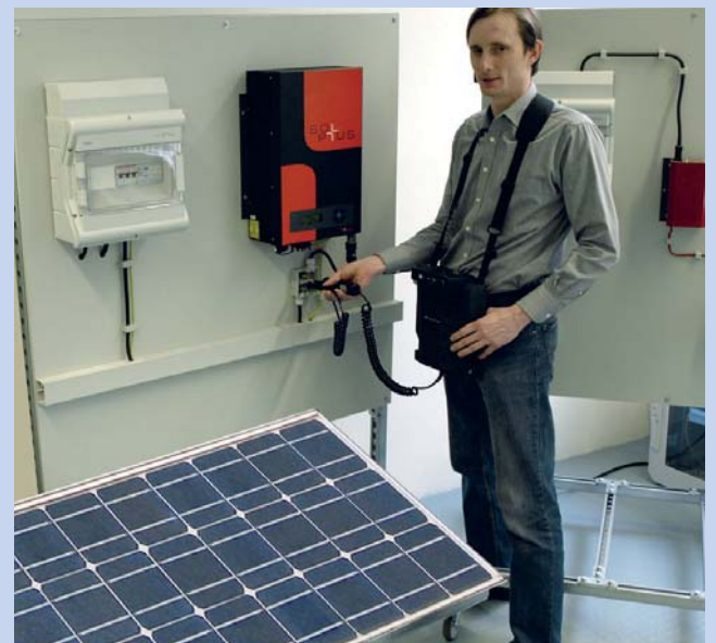
2 Messung an einer Photovoltaik-Anlage
