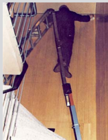
② Leitern mit Holmverlängerungen für kurzzeitige Arbeiten in engen Treppenhäusern
