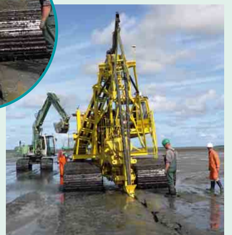
1 Bei der Kabelverlegung im Naturschutzgebiet Wattenmeer wurde ein neuartiger Vibrationspflug eingesetzt
