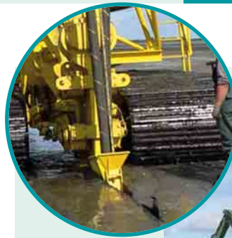
1 Bei der Kabelverlegung im Naturschutzgebiet Wattenmeer wurde ein neuartiger Vibrationspflug eingesetzt
