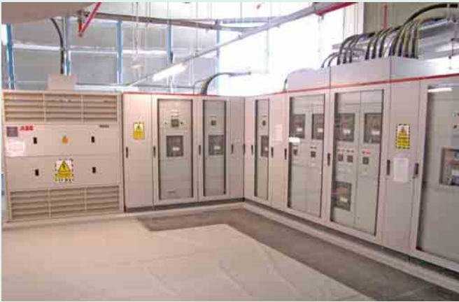
② Beispiel einer Schaltstation (Nieder- und Mittelspannung) mit Trafo (links) im 135. Stockwerk
