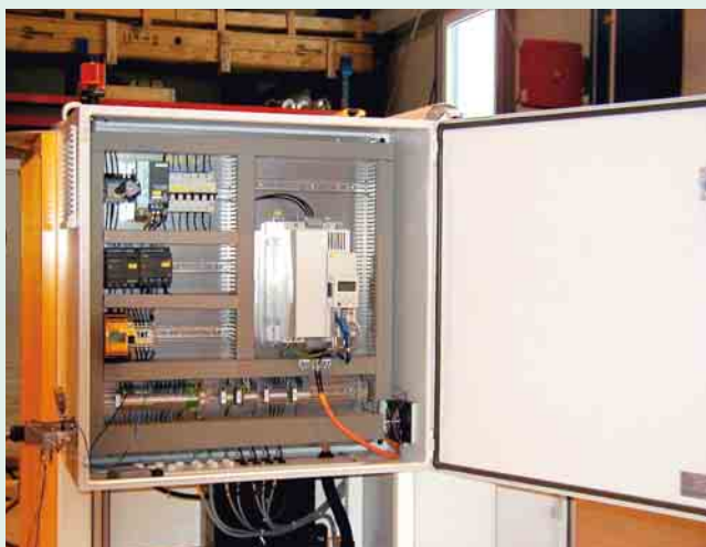
③ Mit seiner Breite von nur 45 mm spart das PNOZmulti Mini Platz im Schaltschrank Fotos: Pilz (2), TNT Maschinenbau (2)
