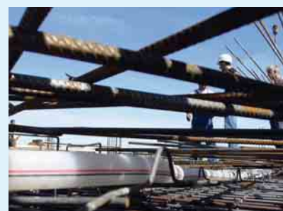
2b Das Verlegen erfolgt zwischen der unteren und oberen Bewehrung
