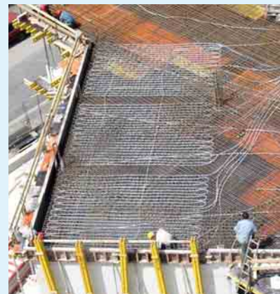
2a Einbringen der Bauteilaktivierung im Freiburger Solar Info Center
