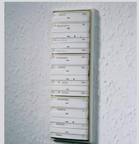
③ An den EIB-Tastern hinter der Theke wird das Geheimnis der „Lichtspiele“ im Ladengeschäft gelöst. Hier können alle Funktionen noch einmal vorgeführt werden, um das EIB-System zu erklären Foto: G I RA
