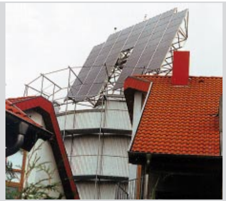
④ Der in 3 Ebenen gegliederte Solarturm - u.a. mit einer PV-Anlage bestückt - dient der Berufsausbildung
