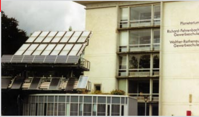
③ 6.6 kWp leistet die 54 m 2 große PV-Anlage. Zur Erhöhung des Energieertrages steht sie fest montiert auf einem drehbaren Rundhaus, das den Solar-generator dem Sonnenstand nachführt (Fotos: 2 - 4 Kabisch)
