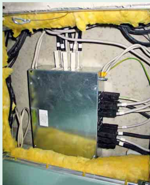
③ Mit individuell vorverdrahteten Systemverteilern wurde die gesamte Elektroinstallation so vorbereitet, dass vor Ort nur noch gesteckt werden musste ▶
