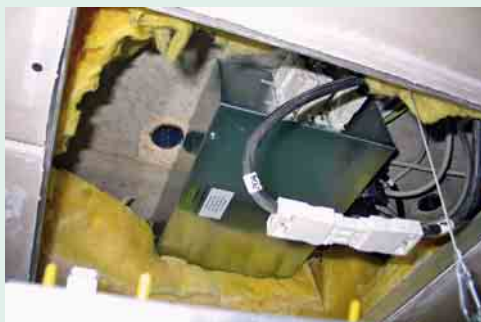
▲ ② Steckverbinder in der Versorgungsleitung und als Einbauvariante am Systemverteiler
