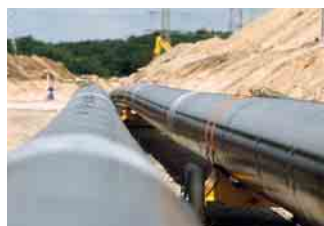
① Die ersten Abschnitte der gasisierten Drehstromleiter wurden, genau wie es im Pipelinebau geschieht, in die vorbereiteten Gräben gelegt
