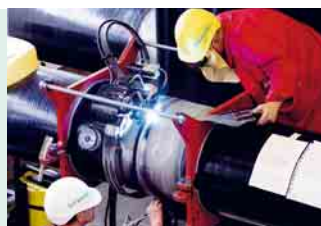
② Die Leiter- und auch die Mantelrohre werden mit einem speziellen Orbital-Schweißautomaten verbunden. Eine Ultraschallprüfung weist die Dichtheit nach
