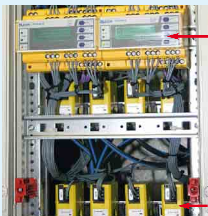
◀ 10 Differenzstrom-Überwachungssystem in einer Anlage bestehend aus RCMS460 und Messstromwandler D Differenzstrom-Überwachungsgerät Typ RCMS 460 M Messstromwandler
