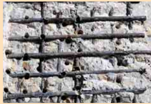
11 Durchbohrte Eisen in der Armierung
