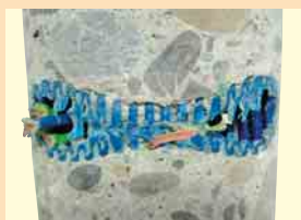
9 Sauber herausgetrennter Bohrkern
