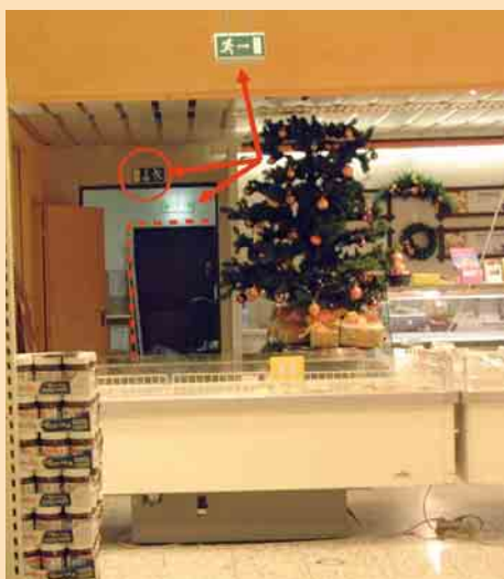
3 Mehrdeutige Fluchtwegkennzeichnung
