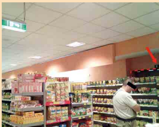
4 Falsche Fluchtwegrichtung durch Nutzungsänderung
