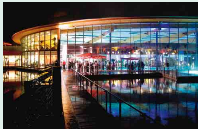
❶ In dem Oskar-Frech-Seebad in Schorndorf wurde die vorgestellte elektroakustische Anlage installiert
