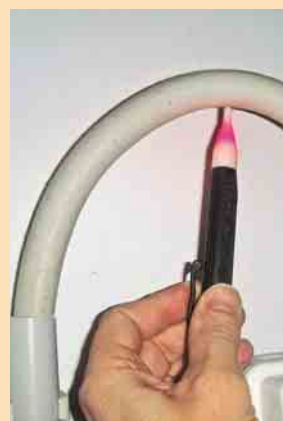
❶ Signalisierung einer anstehenden Spannung mit einem „Polsucher“
