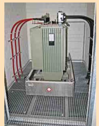
4 630-kVA-Transformator
