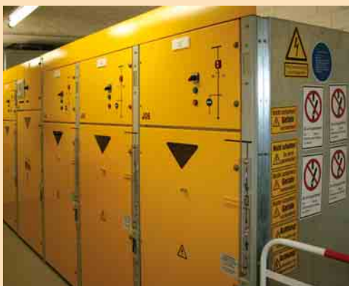
2 Mittelspannungsschaltanlage
