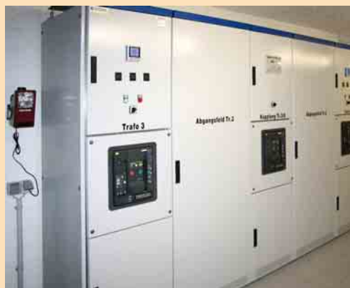
3 Niederspannungsschaltanlage
