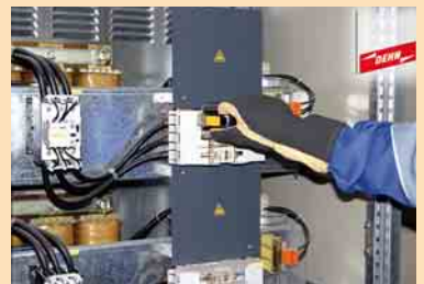
5 Schutzhandschuhe fr elektrotechnische Arbeiten, getestet im Boxtest Klasse 2 Foto: Dehn
