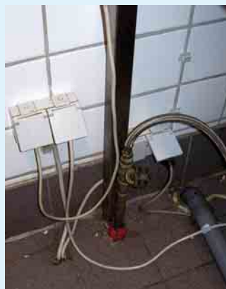
③ Installation unterhalb des Abwaschbereiches
