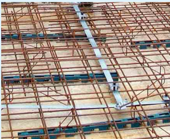
④ Fundamente mit Anschluss an die Bewehrung
