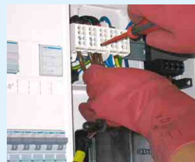
4 Arbeiten unter Spannung mit Isolierhandschuhen und Schutztüllen
