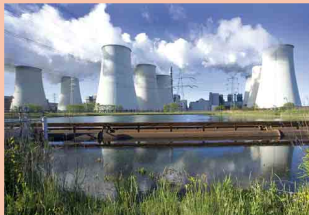
1 Braunkohlekraftwerk Jämschwalde in der Niederlausitz. Mit einer installierten Leistung von 3000 MW ist es das zweitgrößte Kraftwerk Deutschlands
