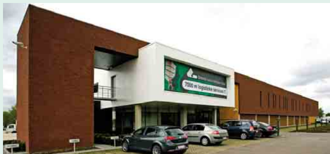
1 Der belgische Großhändler Brevas hat in seinem neuen Stammhaus ein innovatives Beleuchtungskonzept mit funkbasierten Bewegungsmeldern und Touch-Screen-Bediengeräten installiert
