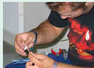
4 Konfektionierung der Kupferstrecken
