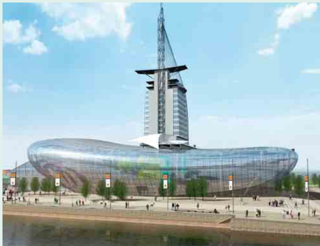
③ Das Klimahaus Bremerhaven 8° Ost ist mit einem EVA-Com-System ausgestattet Quelle: Klimahaus
