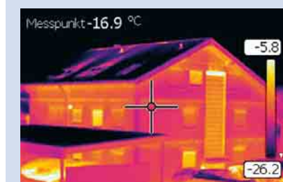
1 Wohnhaus Baujahr 1970, Glasbausteine im Treppenhaus, undichte Dachfenster
