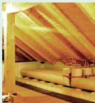
... 2 liegend installiert werden
