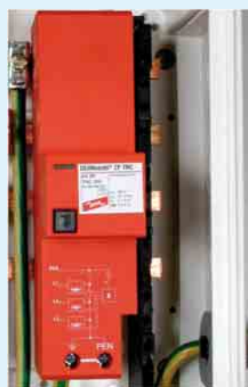
7 Auf die Sammelschienen aufrastbarer dreipoliger Blitzstromableiter für das TN-C-System (3+0-Schaltung)
