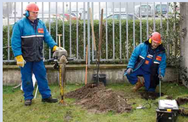
2 Vorbereitung zur Installation eines Tiefernders
