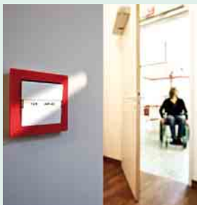
5 Die überbreite Tür zum Badezimmer lässt sich im Flur von außen und im Bad von innen mit einem Schalterklick öffnen
