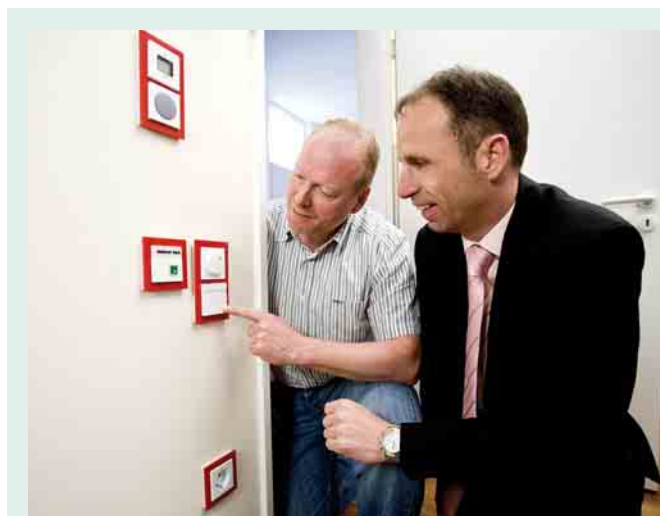
1 Elektromeister Thorsten Fröh (links) und Hubert Holzem (rechts), technischer Außendienstmitarbeiter bei Busch-Jaeger, begutachten die Installation
