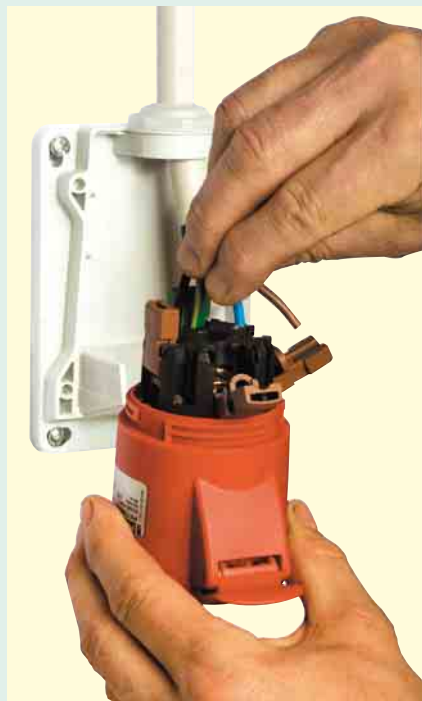
5 Schnelle Montage: Abisolieren der Adern unnötig
