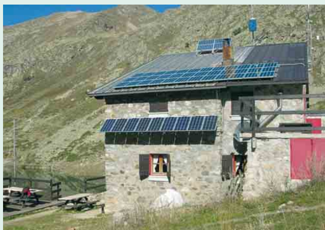
2 Autarke Energieversorgung einer Berghütte Foto: SMA
