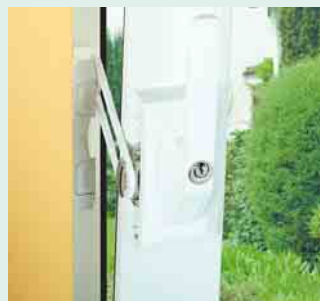
③ Fenstergriffschloss mit Sperrbügel
