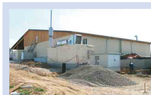
1 Biogasanlage mit BHKW im Bau Quelle: Stadt Leinfelden-Echterdingen
