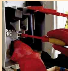
1 Abdecken aktiver Teile beim Arbeiten unter Spannung an Hausanschlusskästen
