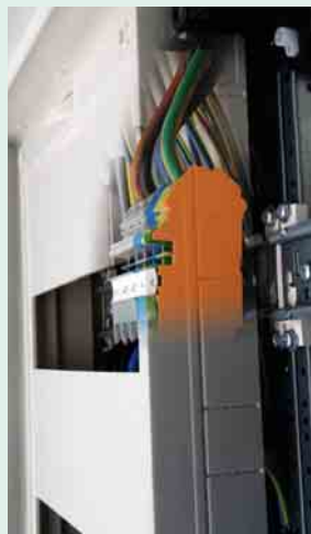
② Detailbild der Sammel-schieneaufnahme
