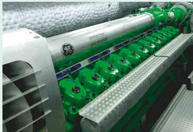
1 Die 4-MW-Motoren wurden speziell für den BHKW-Einsatz entwickelt
