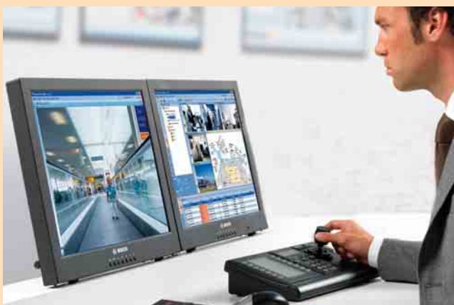
1 Beispiel eines Überwachungsplatzes
