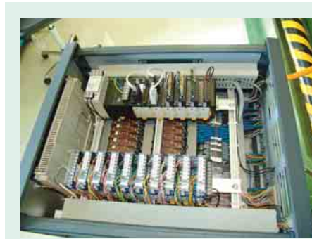
2 Die SPS ermöglicht zusammen mit den Temperaturreglern, dass auf Knopfdruck das erforderliche Temperaturprofil in der Schnittzone während des gesamten Durchgangs konstant bleibt
