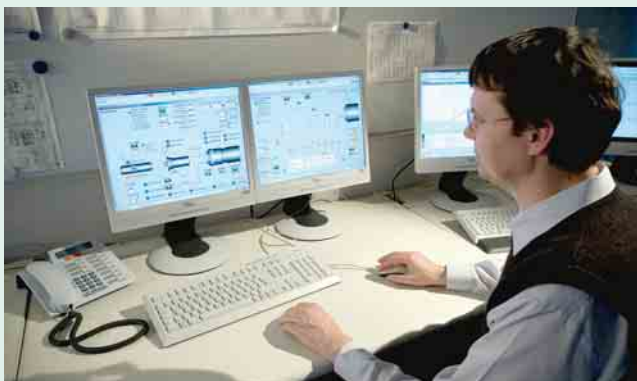
4 Anfahren der Gasturbine SGT5-8000H mit dem erweiterten Leittechniksystem
