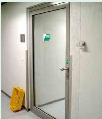
② Direkt neben den Zugängen zu nicht-öffentlichen Bereichen wurden die Finger-Sensoren installiert
